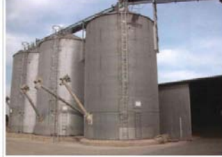
En esta segunda parte se analiza las instalaciones en las que se realiza el secado de los granos, así como algunas características de los combustibles que se utilizan en los secaderos.
