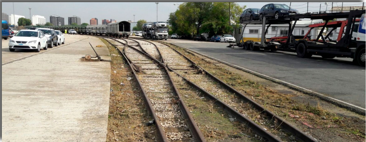
Vías ferroviarias antes y después del tratamiento. Imágenes cedidas por SINTRA
