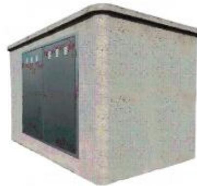
Figura 16. Detalle de caseta por hidrantes.
