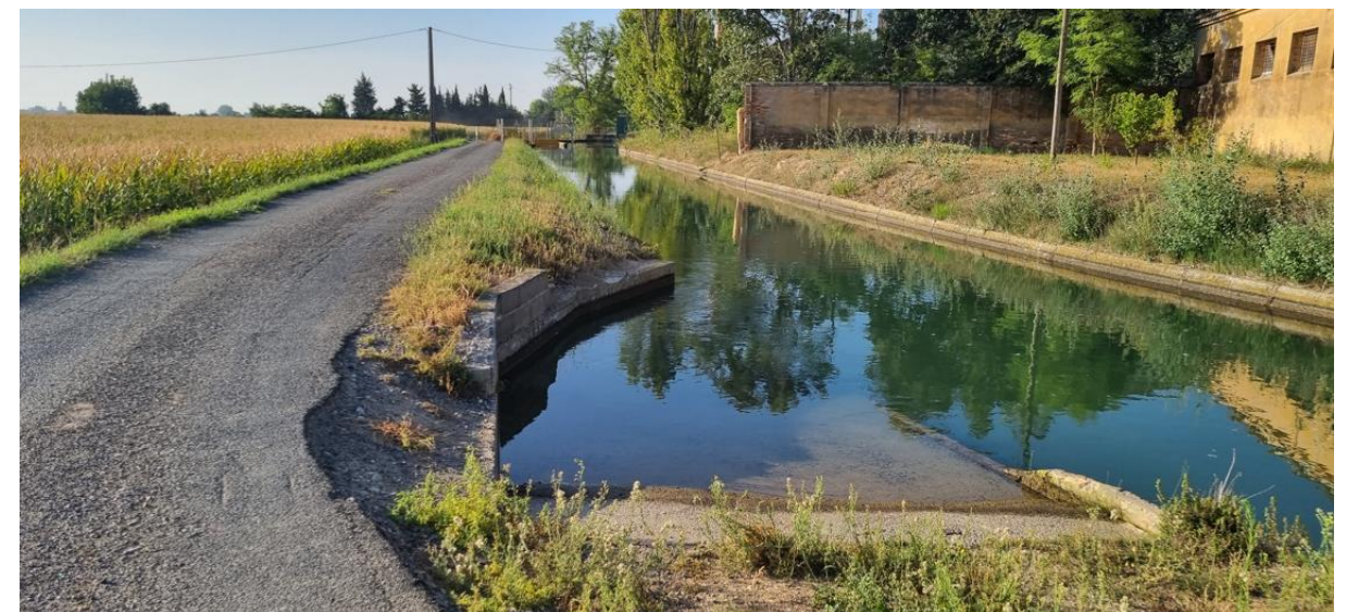
Figura 97. Rampa de acceso existente en el canal principal. La rampa está localizada a unos 10 metros aguas abajo de la futura obra de captación.
