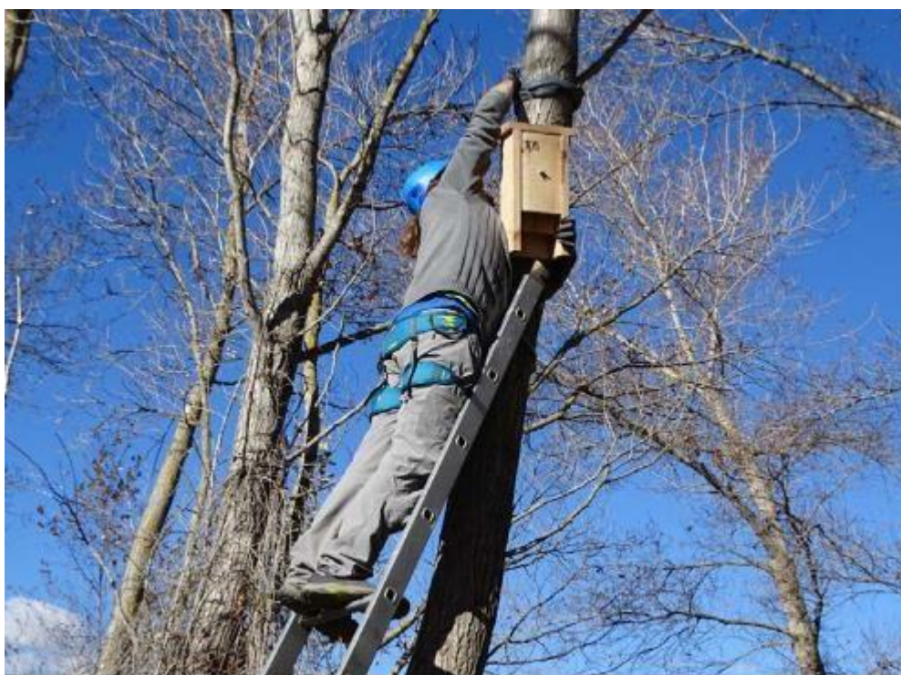
Figura 100. Instalación de refugio para murciélago. Obsérvese como el acceso está abierto en la base del refugio. Fuente: ANSE
